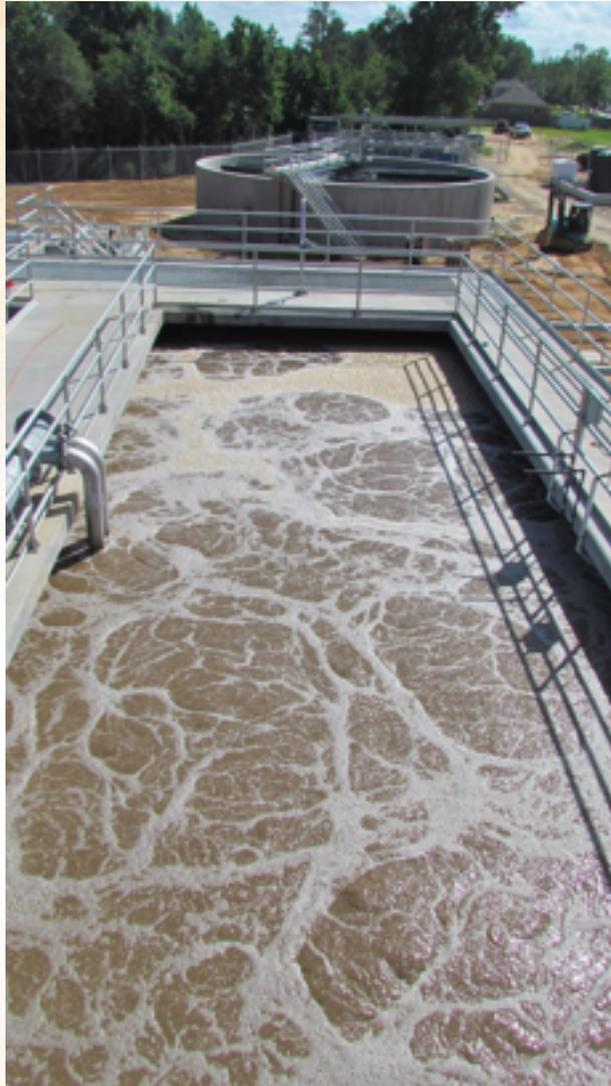
Figure 3: Top of Aerator - Clarifier - Effluent Filter - Effluent Chlorination
